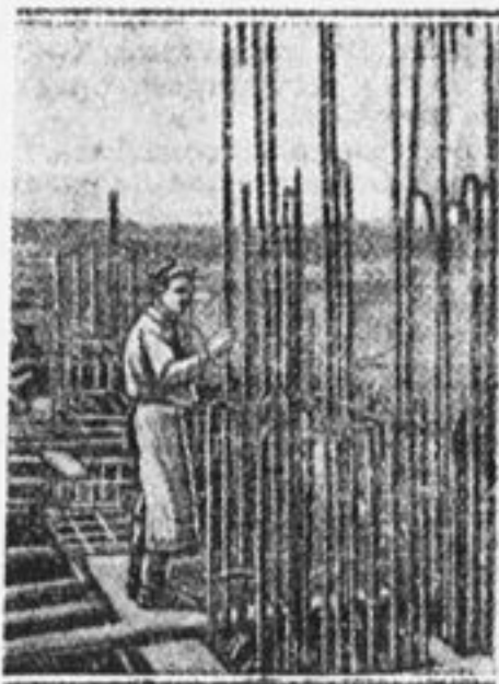
Закладка фундамента. Укрепляют арматуру.
